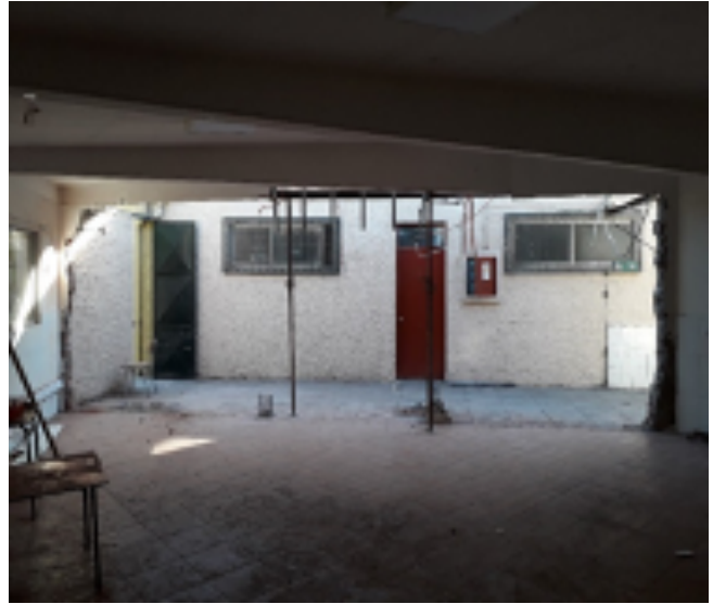
La construcción avanza en el Liceo José Domingo Cañas
